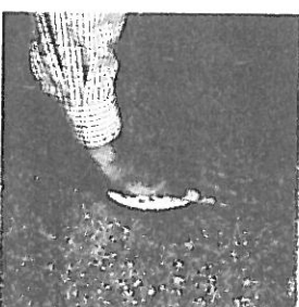
6. Lagg klämringen på plats med texten uppåt. Placera silen ovanpå och tryck till med handen. OBS! Kontrollera att klämringen är nertryckt i sitt bottenläge.
